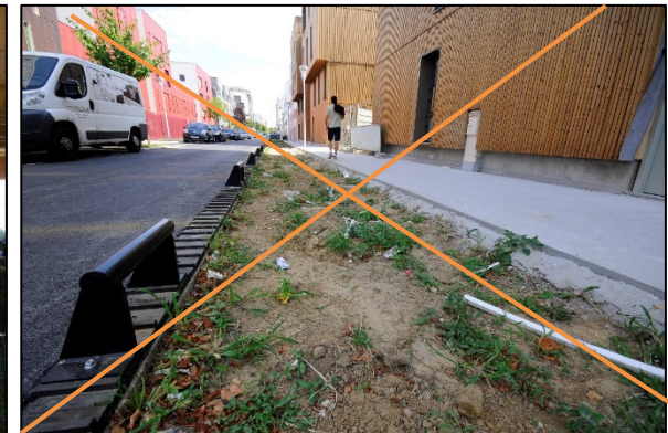
Construction sur pieux (Colombes) – Noues compactées (Nanterre)
