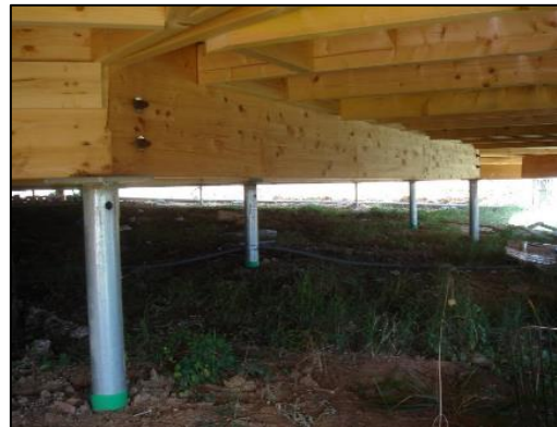
Construction sur pieux (Colombes) – Noues compactées (Nanterre)
